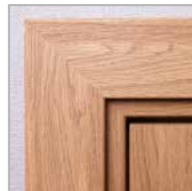
standardowe łączenie opasek pod kątem 45°
